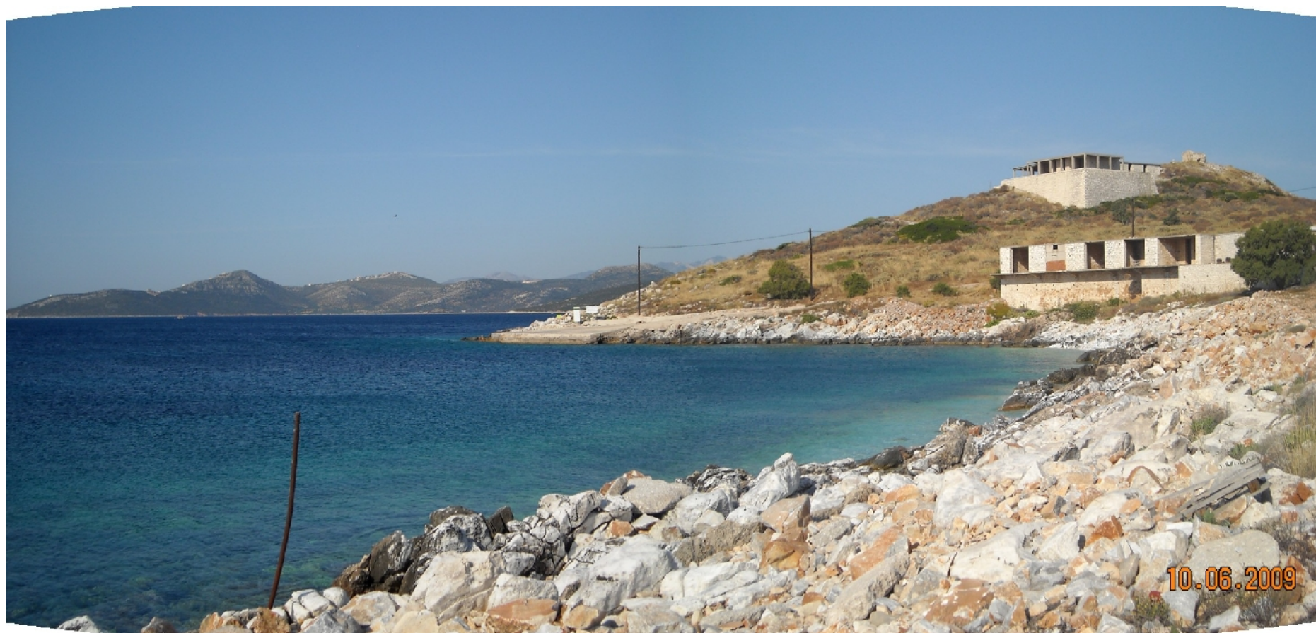
Φωτ. 20 Νότια παραλία. Άποψη από ανατολικά προς δυτικά της βραχώδους ακτής όπου πρόκειται να κατασκευασθούν τα έργα πρόσβασης.
