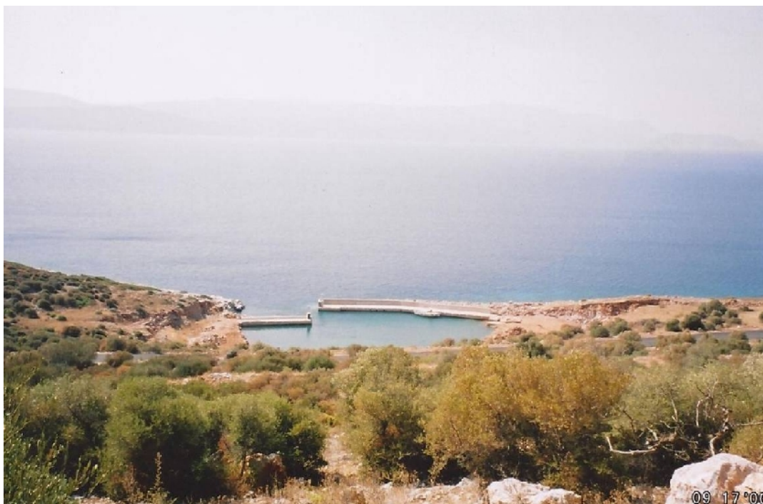
Φωτ. 11 Γενική άποψη του κατασκευασμένου λιμενίσκου σκαφών αναψυχής στη θέση Στάνη.
