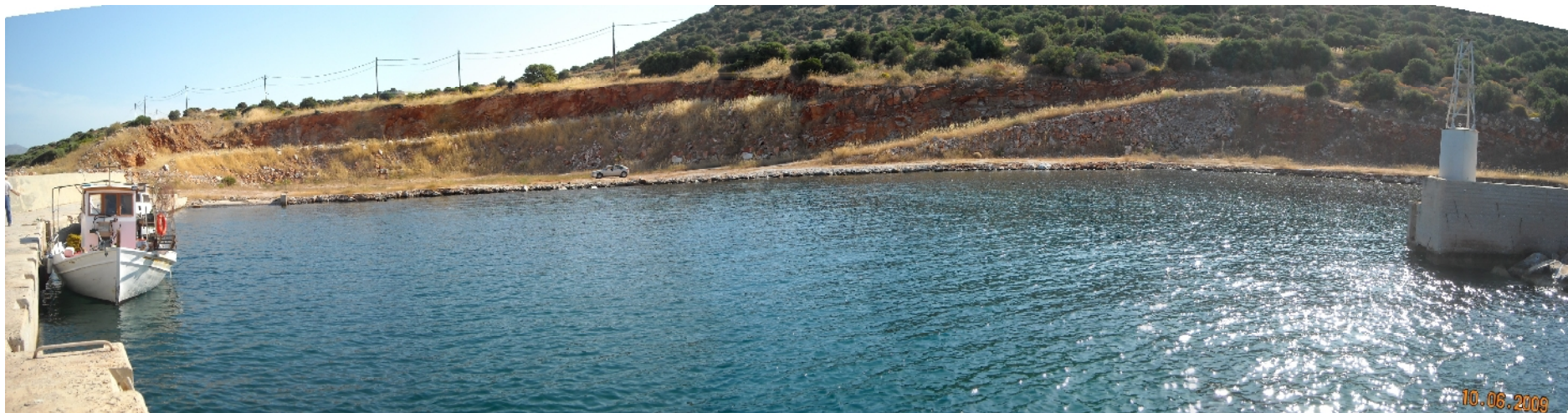
Φωτ. 13 Άποψη του κατασκευασμένου λιμενίσκου στη θέση Στάνη
