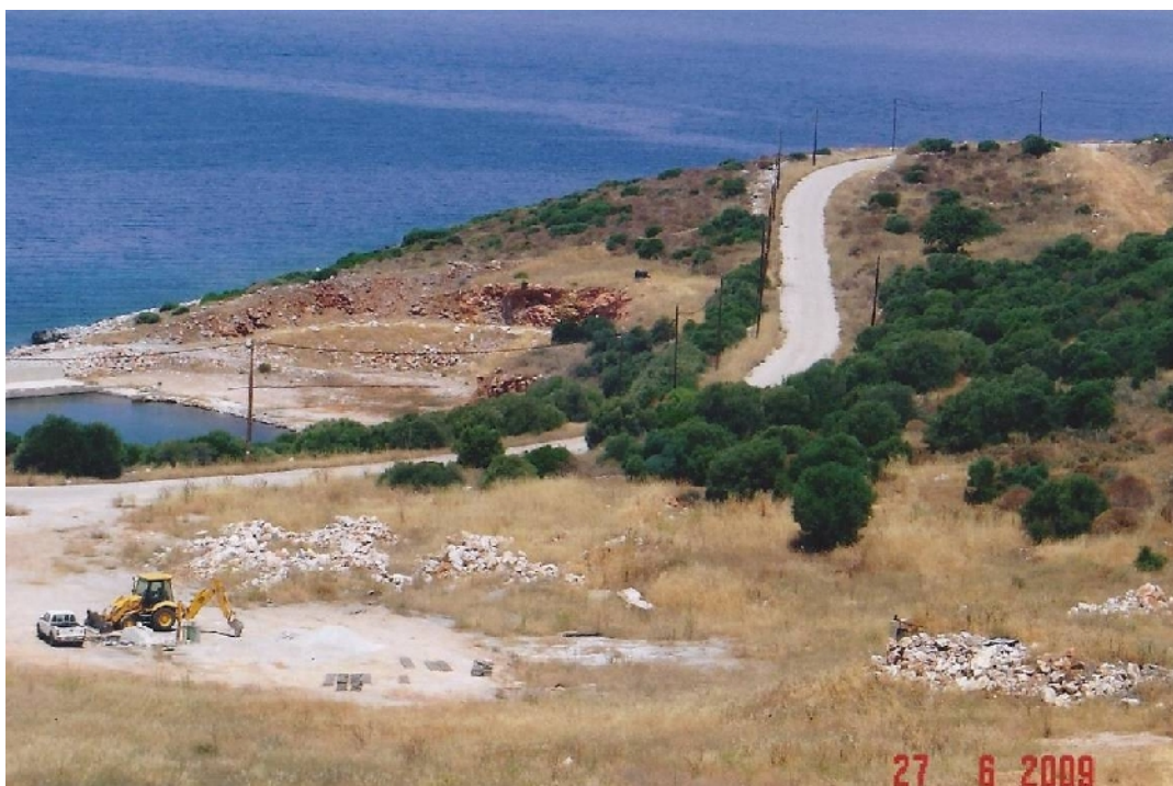
Φωτ. 12 Άποψη της διανοιγμένης και ασφαλτοστρωμένης περιφερειακής οδού του νησιού στην περιοχή του λιμενίσκου σκαφών αναψυχής στη θέση Στάνη.
