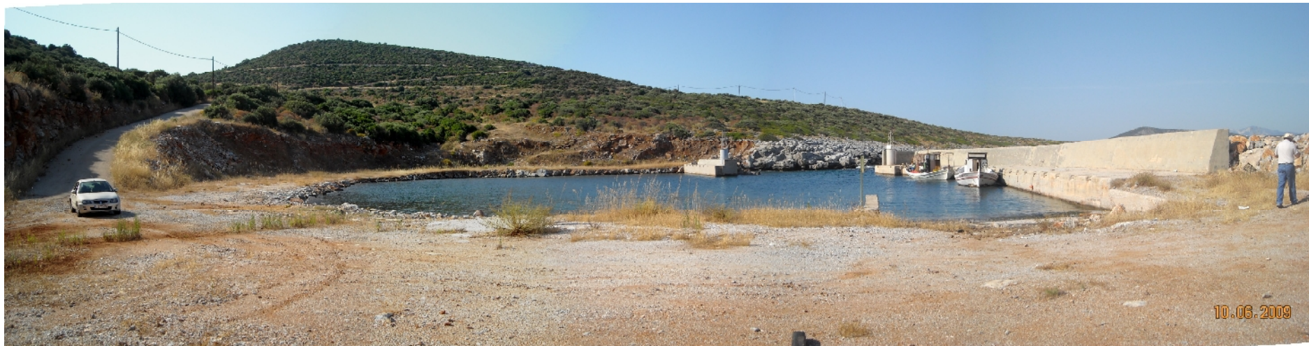
Φωτ. 14 Άποψη του κατασκευασμένου λιμενίσκου στη θέση Στάνη. Στα αριστερά διακρίνεται η ασφαλτοστρωμένη οδός σύνδεσης του με το υπόλοιπο οδικό δίκτυο της Καβαλιανής.
