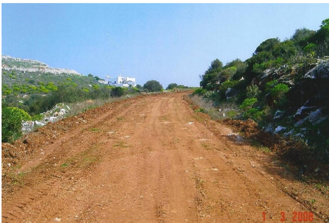
Φωτ. 15 και Φωτ. 16 Άποψη του διανοιγμένου οδικού δικτύου στη Καβαλιανή. Υπολείπονται εργασίες κατασκευής του οδοστρώματος σε μήκος 8,5 km περίπου.
