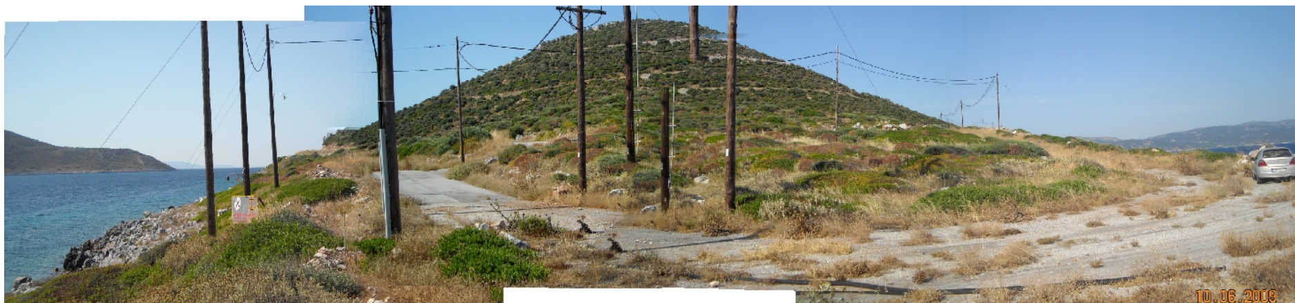
Φωτ. 10 Άποψη της θέσης σύνδεσης της Καβαλλιανής με το δίκτυο της ΔΕΗ μέσω υποβρύχιου καλωδίου. Διακρίνεται οτ ήδη κατασκευασμένο δίκτυο ηλεκτροδότησης
